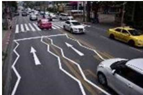
รูปที่ 6.2-13 เส้นซิกแซกหรือเส้นเตือนก่อนถึงทางข้าม
