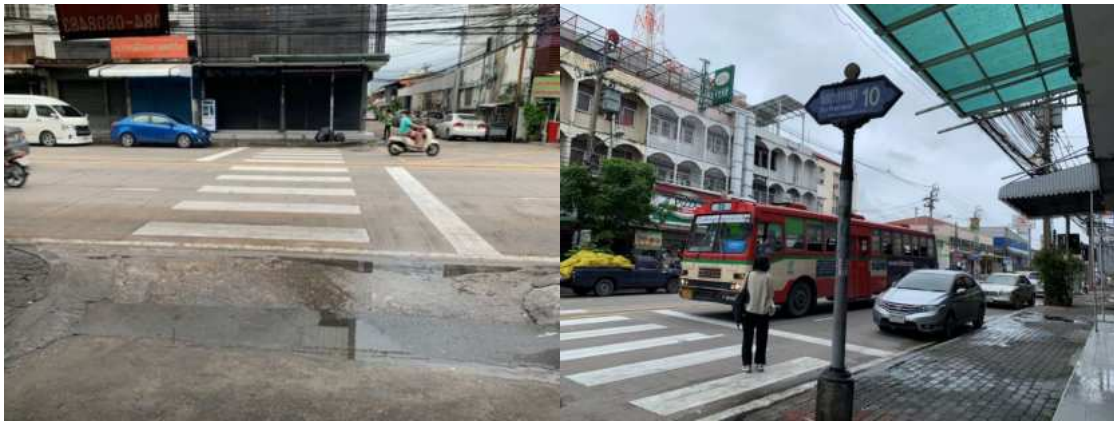
รูปที่ 6.1-1 ทางข้ามบนทางหลวงหมายเลข 306 ตอน 101 กม. 4+970
