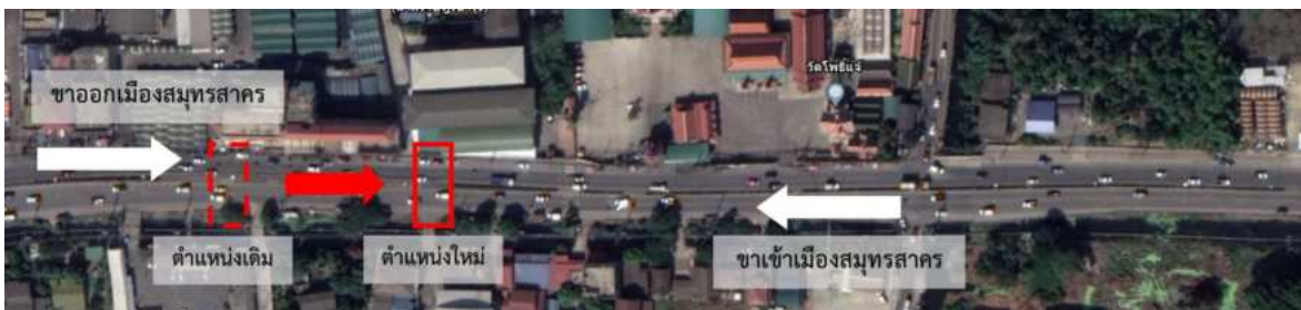
รูปที่ 6.1-6 ตำแหน่งทางข้ามบนทางหลวงหมายเลข 3242 ตอน 100 กม. 11+625
