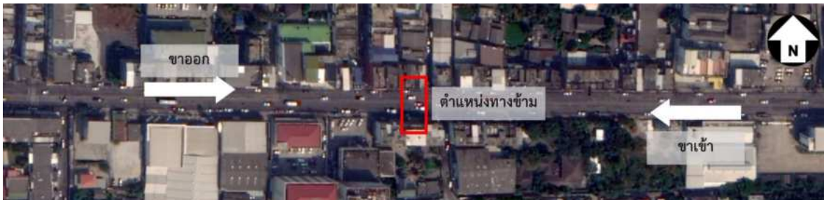
รูปที่ 6.1-2 ตำแหน่งทางข้ามบนทางหลวงหมายเลข 306 ตอน 101 กม. 4+970
