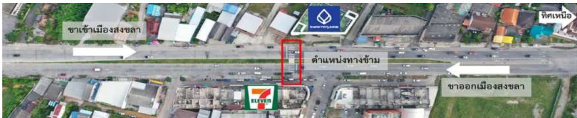
รูปที่ 6.1-10 ตำแหน่งทางข้ามบนทางหลวงหมายเลข 407 ตอน 102 กม. 22+180
