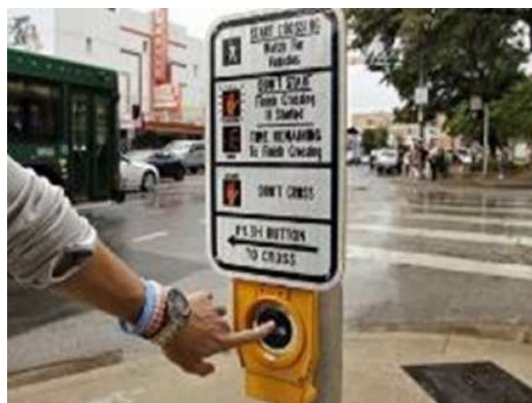
รูปที่ 6.2-6 ปุ่มกดทางข้าม (ที่มา: https://azmag.gov/ )
